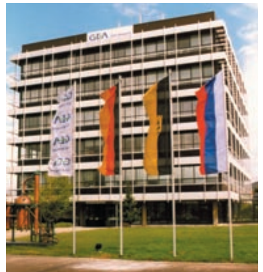
GEA Wiegand à Ettlingen, Allemagne
